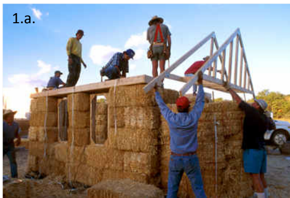
1.a. ábra. Teherhordó típusú szalmaház építés közben 1.b. ábra. Szalmabála falazattal épült templom az USA-ban (1927)
