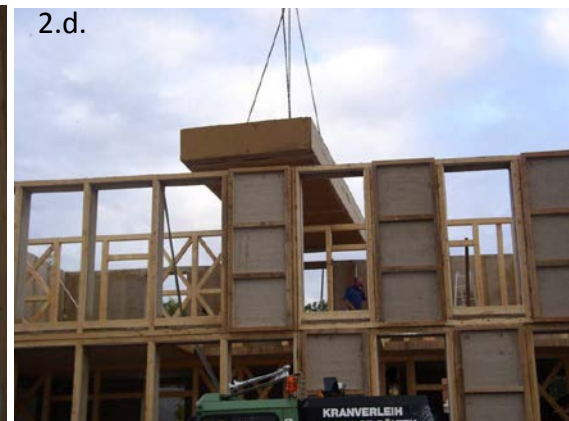
2.a. és c. ábra. Tattendorfi (Ausztria) passzív szalmaház külső és belső képe 2.b. ábra. Építőanyagok beépített energiája CO 2 egyenértékben 2.d. ábra. Tattendorfi (Ausztria) passzív szalmaház építése előregyártott panelekből
