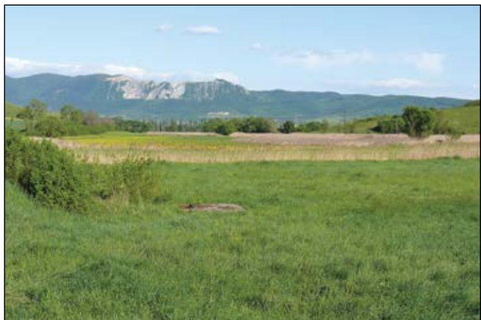
Bekölce: (48.0793;20.2830) KDK-felé. Szemben a Bél-kő 2002-ben felhagyott bányászata után visszamaradt durva tájseb. (2016. május)
