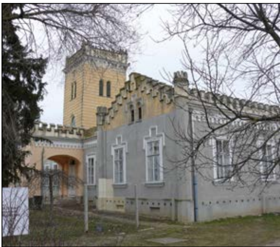
Zsáka: a tájra jellemző magas talajvízállás falakat átmedve-sítő hatása ellen szellőztető kerámiaacsoveket építettek be a volt Rhédey-kastély lábazatába (2019. február)
