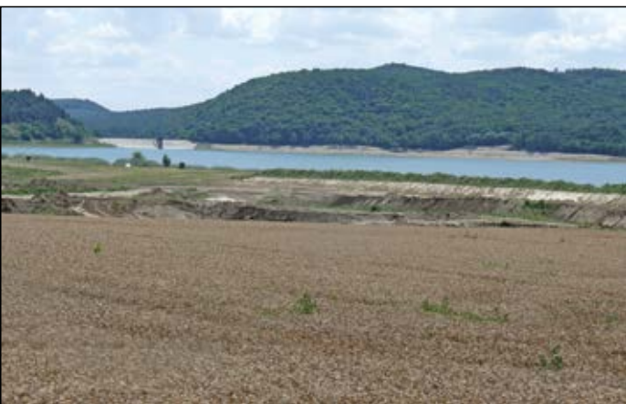
Fehérvárcurgó: völgyzárógát és a Csurgói-tó (2019. július)
