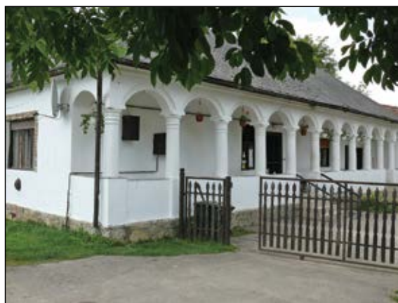
Nagyvisnyó: felújított tornácos ház (2016. május)
