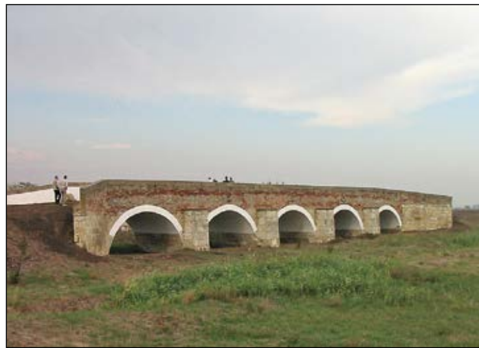
Karcag: Zádor-híd (épült 1806-09), amely alól a 19. századi vízrendezések során elterelték a vízfolyást... (2003. október)
