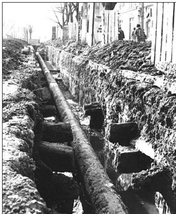
Debrecen: a 19. sz. közepéig sáros időszakban a főútcán a közlekedést egy ún. Nagyhid segítette. Ennek gerendáit tartta fel egy vezetéképítés 1984-ben.
