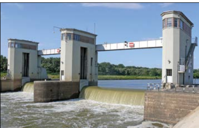
Békésszentandrás: vízlépcső és vízerőmű (épült 1936-1942 között) (2019. június)
