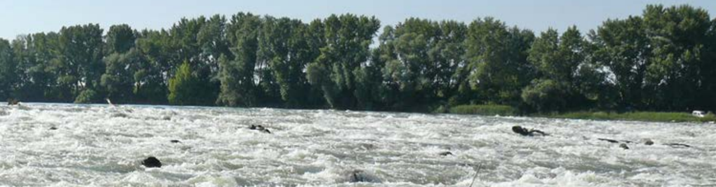
Dunakiliti–Feketeerdő: (47.9672;17.3340) ÉNy-felé. Vízfolyásgyorsító és vízlevegőztető mesterséges gát, az ún. fenékküszöb. (2015. június)
