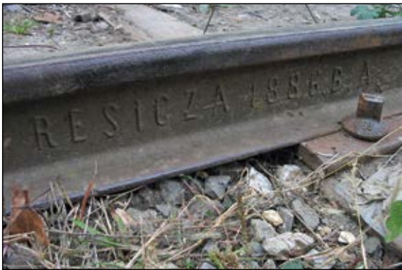
Alsózsolca: sín a nagy hazai vasútépítés korából (2004. október)
