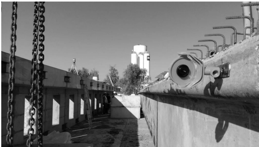
2. ábra Miniprizmák rögzítése a gerendavállon
